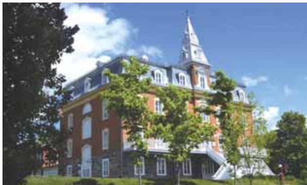
Le couvent (1887-1888) Architecte : Joseph-Ferdinand Peachy Pensionnat et école pour filles administré par les Sœurs de la Charité. Devenu la Maison de la culture en 1993, on y retrouve le Musée Marius-Barbeau, la Société du patrimoine des Beaucerons et son centre régional d'archives et la bibliothèque municipale.
